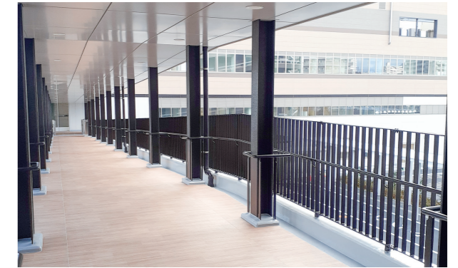
立体駐車場と病院をつなぐ渡り廊下で、雨の日も濡れずに快適に移動ができます。
